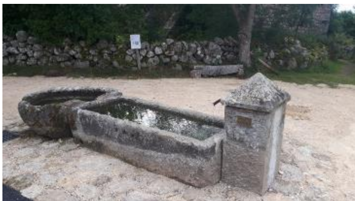
Les deux fontaines ont été dégagées du sol et un dallage en pierres sèches a été réalisé.
