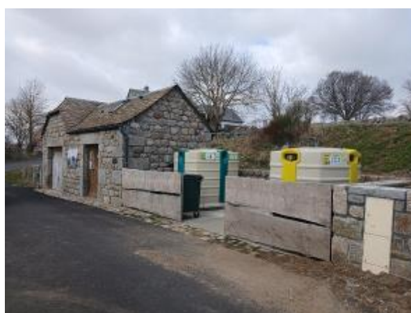
Extension de la zone des containers, un bac jaune emballages a été ajouté
